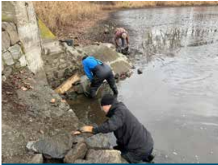
Großteich Burkartshain, Mönchreparatur
